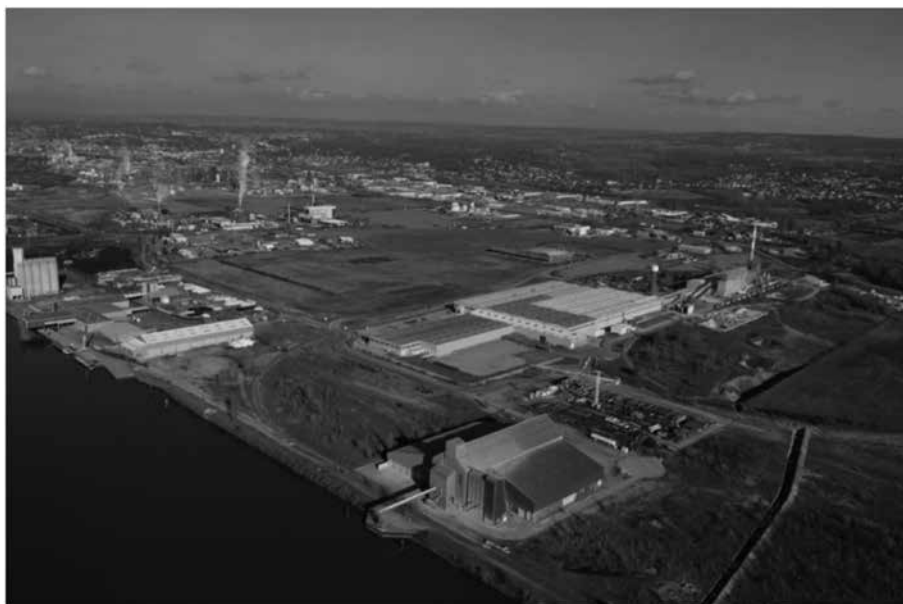
Figure 3 : Vue aérienne de l'espace industriel INSPIRA
