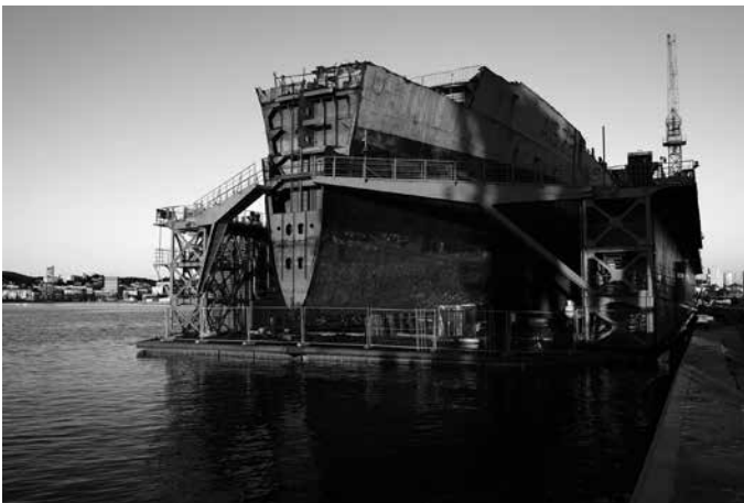
Figure 1 : Opération de démantèlement de l'ex-pétrolier-ravitailleur Saône
