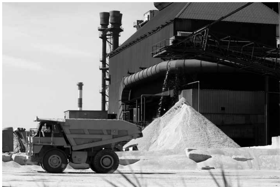
Figure 7 : Photo du haut-fourneau
